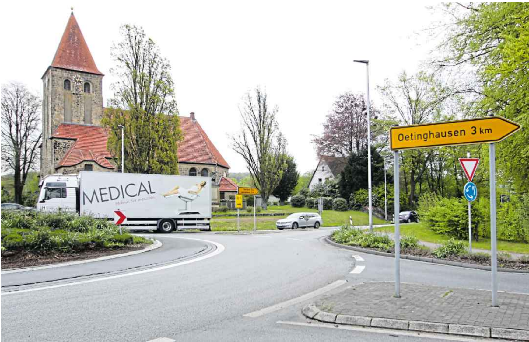
Auch der große Kreisverkehr an der Eilshauser Kirche erhält eine neue Fahrbahndecke. Die Arbeiten sollen voraussichtlich Ende Mai/Anfang Juni beginnen und bis Mitte August dauern.
